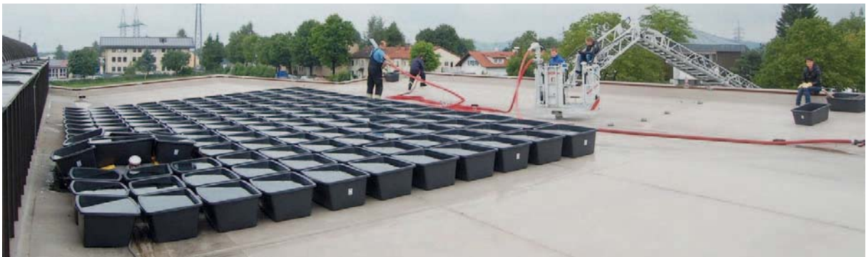
Abb. 5: Künstliche Last auf dem Dach der Turnhalle, bestehend aus 154 mit Wasser gefüllten 90-l-Mörtelkästen, unmittelbar nach Abschluss des Befüllvorgangs
