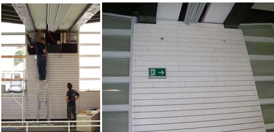
Abbildung 7: Kameras unterhalb der Auflager der Hauptträger, während (links) und nach Abschluss der Montagearbeiten (rechts)
