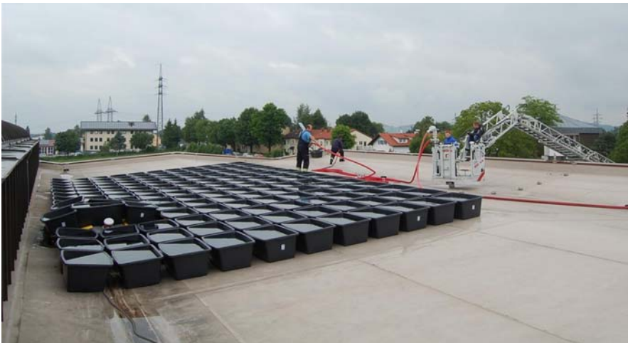
Abbildung 10: Künstliche Last auf dem Dach der Turnhalle, bestehend aus 154 wassergefüllten 90l-Mörtelkästen, unmittelbar nach Abschluss des Befüllvorgangs
